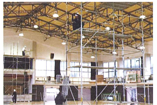
体育館補修の様子
