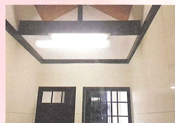
④4階本館西側階段側の小部屋と天井
