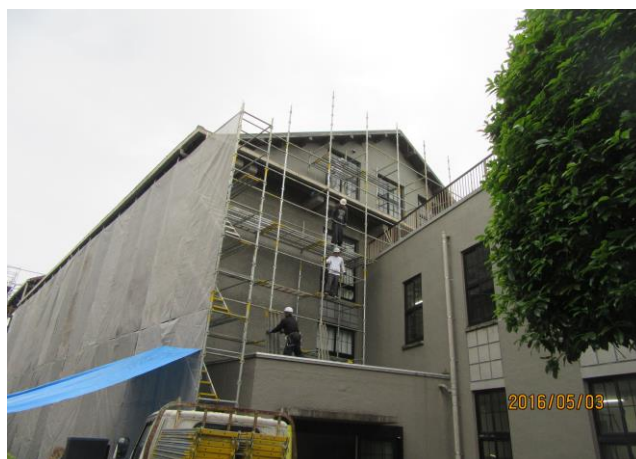
②本館西側つま部分の補修工事
