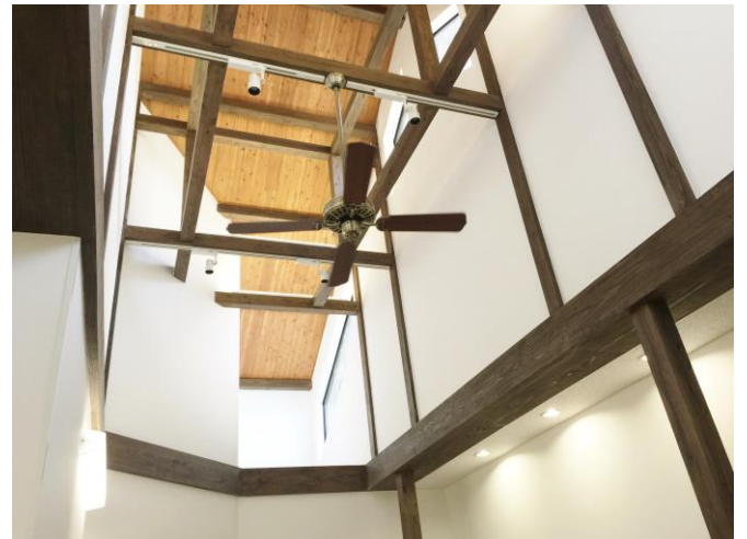
⑧ 4階、吹き抜け部分と天窓
