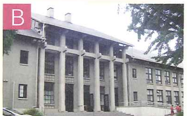
高校校舎 熊本市重要文化財指定を受けている伝統的な校舎です。
