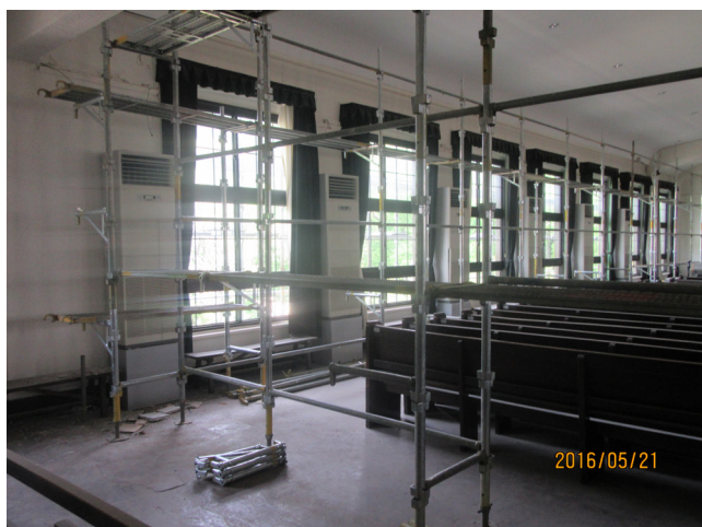
①礼拝堂の修復の様子（天井アーチ補修の足場）
