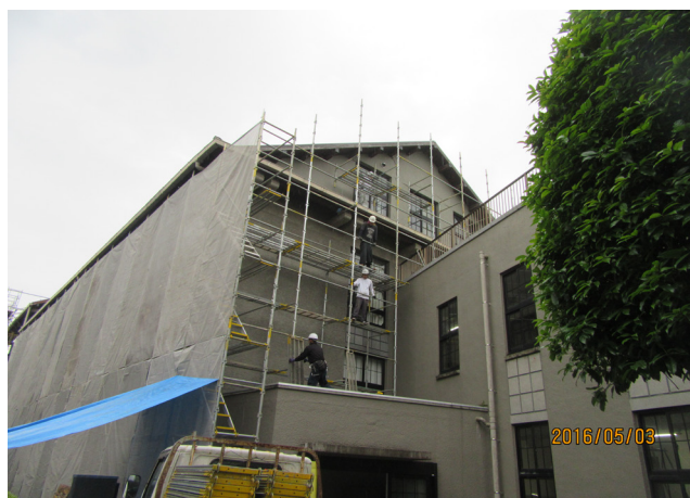
②本館西側つま部分の補修工事
